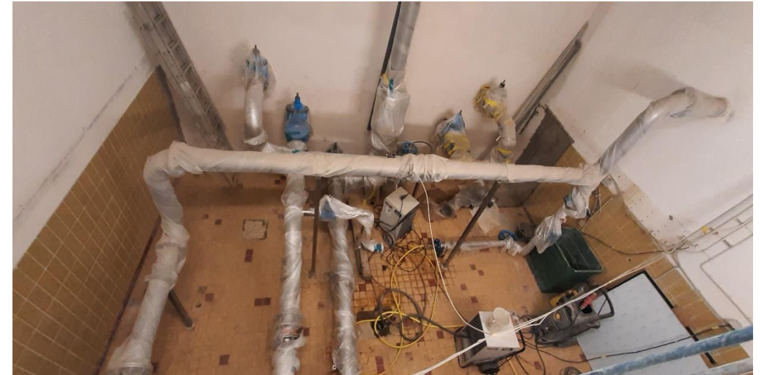
ROHRKELLER NEU EDELSTAHL
